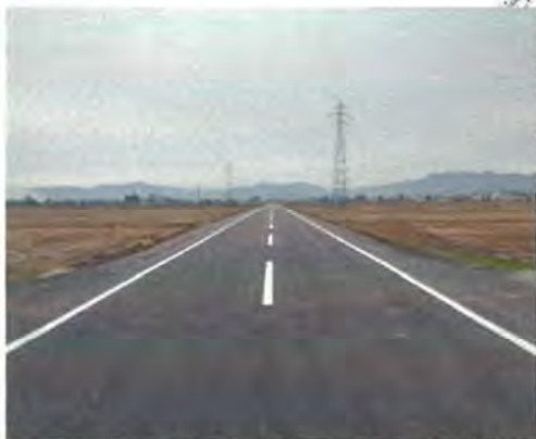
町道西町津久茂西線改良完成写真
