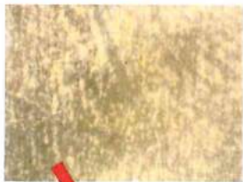
【変色部の外観】
